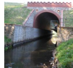
Akwedukt w Fojutowie
