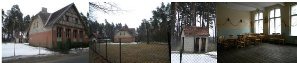
Świetlica wiejska w Lipowej
